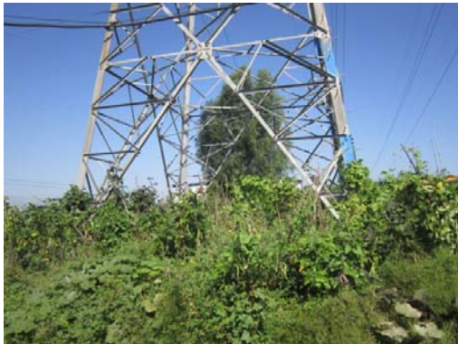
塔基生态恢复 3
