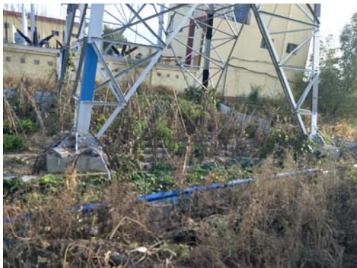
塔基生态恢复 5
