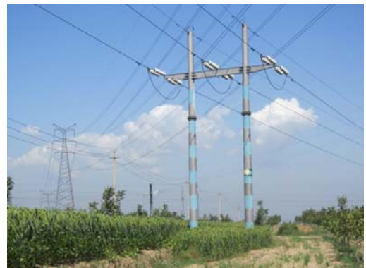
塔基生态恢复 6
