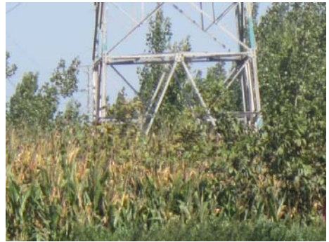
塔基生态恢复 2
