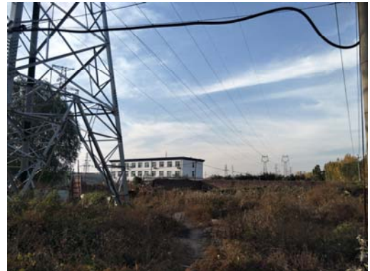
塔基生态恢复 4
