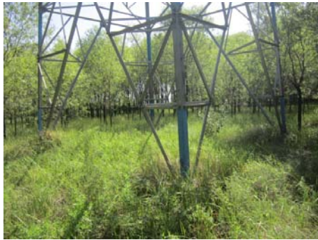
塔基生态恢复 1
